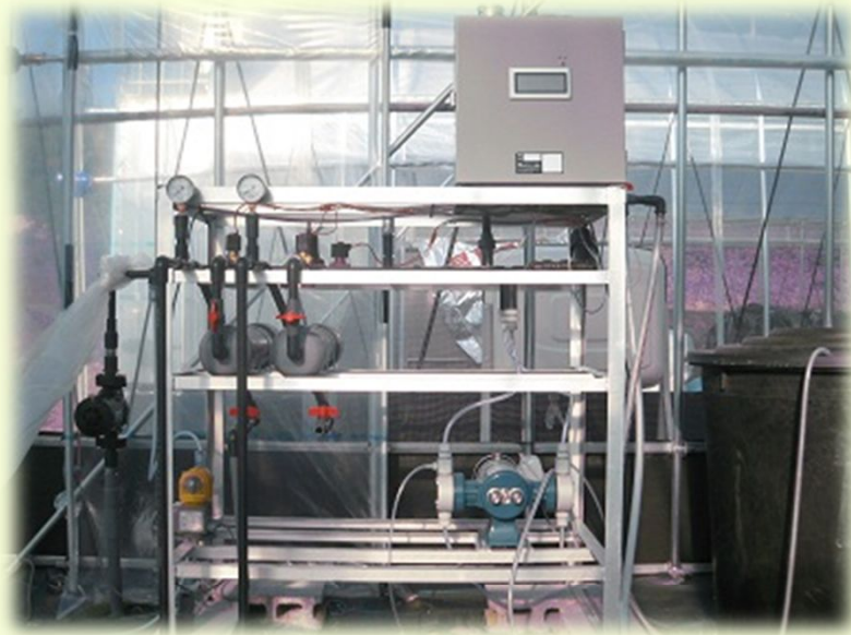
写真は増設ユニットを2系統取り付け
